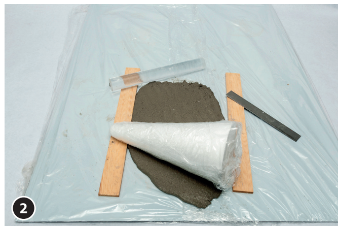
2 Avvolgi il cono di polistirolo con la pellicola. Applica la piastra di calcestruzzo sul cono.
