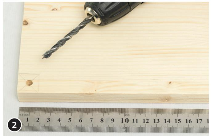
2 Bohren Sie an den Außenkanten, im Abstand von ca. 2 x 2 cm, 6 mm große Löcher.
